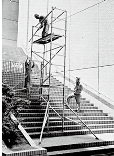
最大900mmまでのレッグ調整が瞬時に可能。 段差のある場所でも安全な作業足場の確保ができます。
